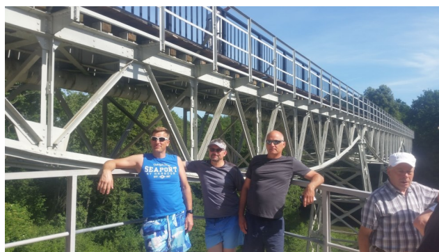
Most Kolejki Wąskotorowej na trasie Koronowo-Okole
