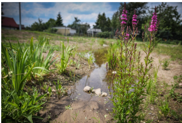
Ogród deszczowy przy ul. Kaczeńce 31, Gdańsk Stogi
