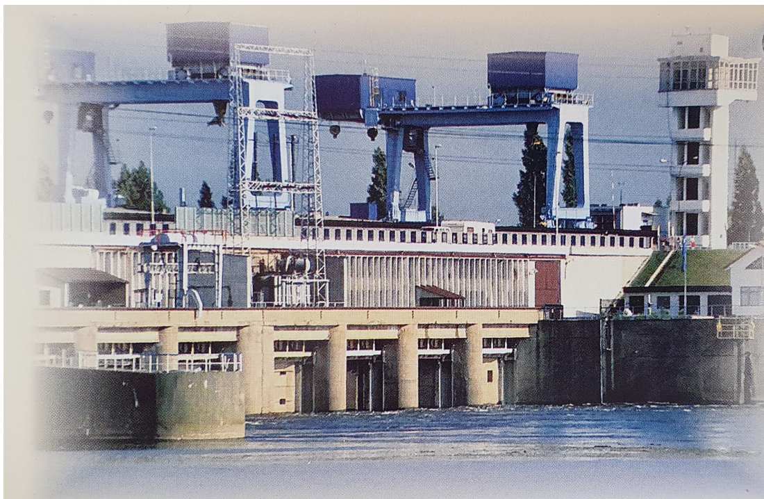
Ogólny widok na siłownię elektrowni wodnej
