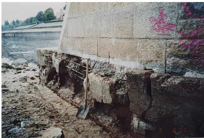
Stan fundamentów przed remontem
