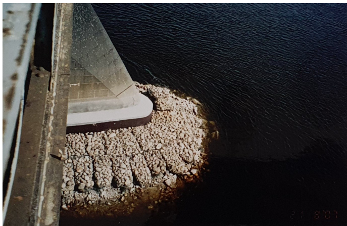
Zabudowa fundamentów filara
