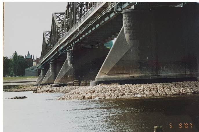
Fundamenty podpór po remoncie
