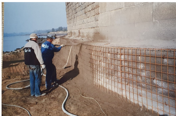
Torkretowanie (narzut betonu pod ciśnieniem) fundamentów
