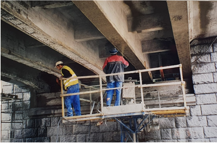
Remont konstrukcji wiaduktu od strony katedry
