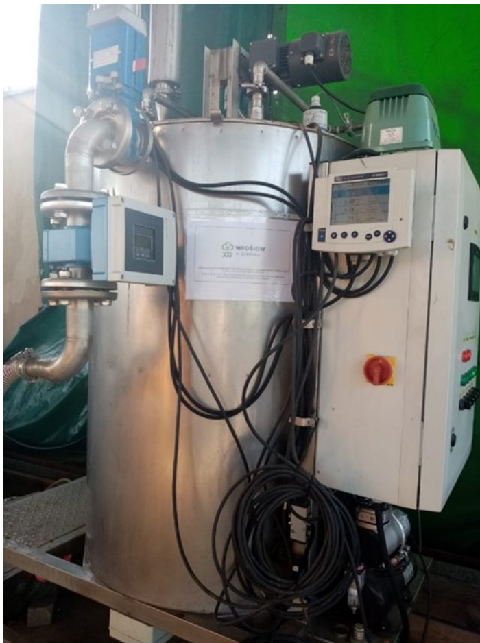
Fot. 1. Reaktor dezintegracji niskotemperaturowej w Oczyszczalni Ścieków w Kozyckowie (fot. własna)
