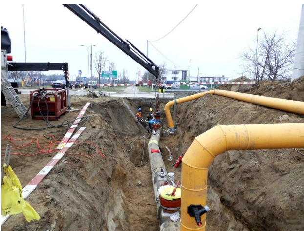
Budowa Pomorskiej Kolei Metropolitalnej - przebudowa gazuociągu zasilającego Gdańsk bez zatrzymania przepływu
