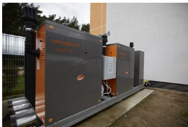
Rys.11. Dwie absorpcyjne pompy ciepła typu GAHP-A i kocioł gazowy AY w budynku wielorodzinnym w Przytocznej [4]
